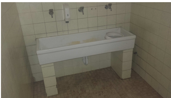
Scuola Primaria Guarino da Verona Ante lavori
