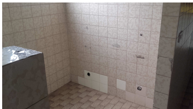
Scuola Primaria Ariosto Ante lavori
